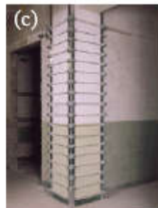
روش استفاده از پیش تنیدگی موضعی در مقاوم سازی تیرهای بتنی
